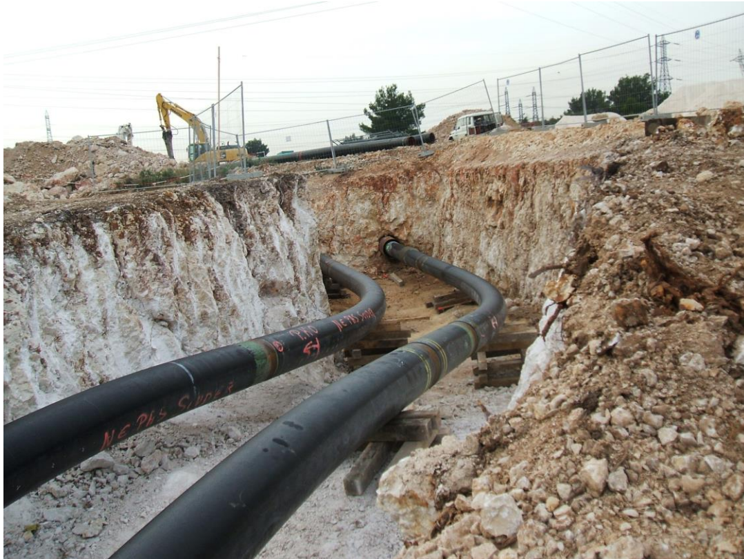
Exemple de canalisation NaTran avant enfouissement
