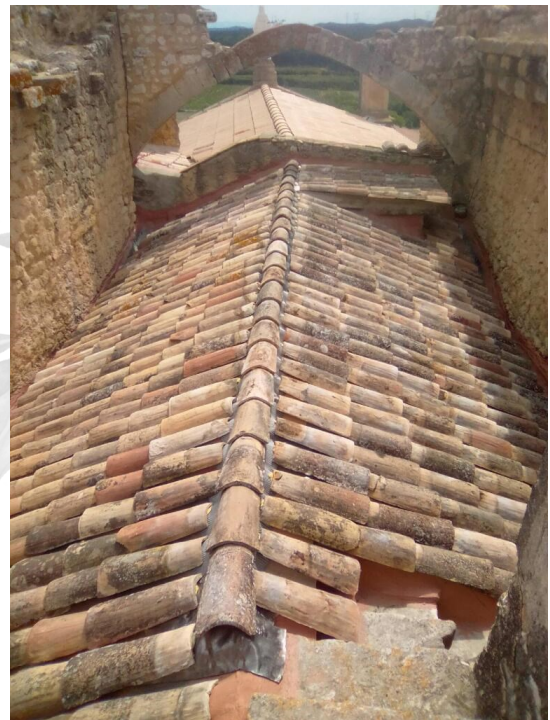
APRES LES TRAVAUX
