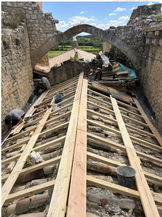
PENDANT LES TRAVAUX
