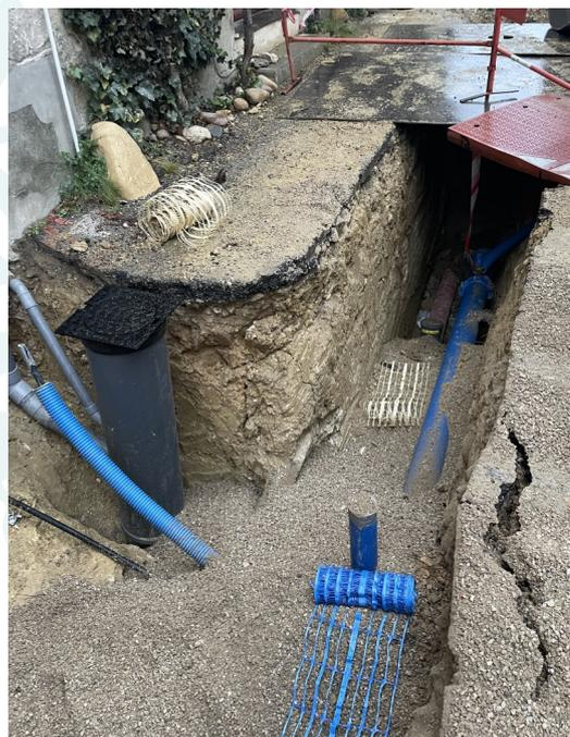
Les travaux effectués consistent à changer toutes les canalisations d'eau potable et remplacer les canalisations d'évacuation des eaux usées actuellement en amiante par des tuyaux PVC.
