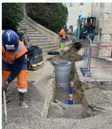
Depuis le 08/11/2023 des travaux de réhabilitation des réseaux d'eau potable et eaux usées sont en cours rue de la fontaine et ce jusqu'à fin janvier 2024 au plus tard.
