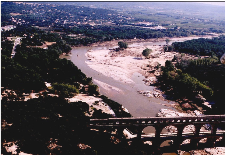
Le site du Pont du Gard, dévasté par la crue (photo Strategis)
