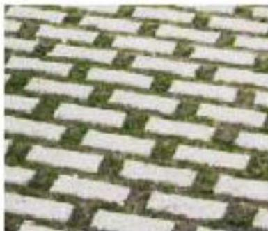
Pavage en béton avec ouvertures de drainage
